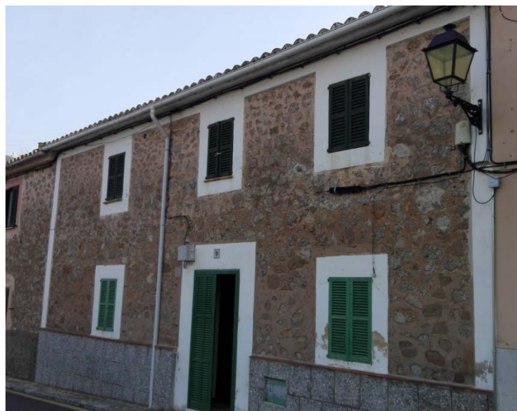
Imagen 8. Fachada principal de la vivienda situada en la calle Llum, número 9.
