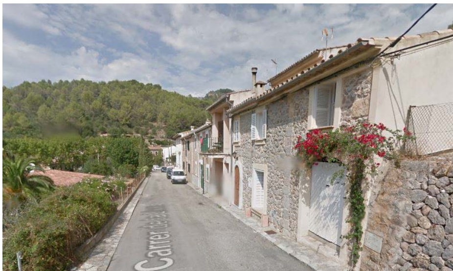
Imagen 5. Carrer de la Llum en escorzo vista desde el centro hacia el norte, donde se aprecia otro núcleo de edificaciones entre medianeras construidas al amparo de normativa anterior a la vigente.
