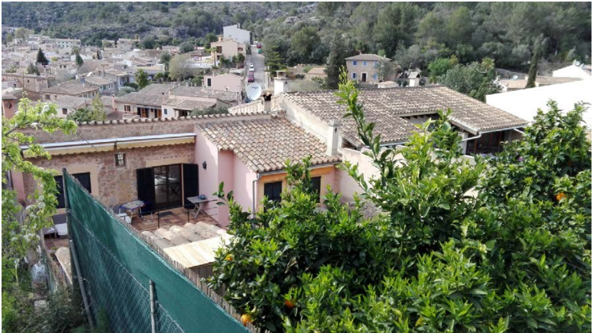
Imagen 48. Fachadas posteriores de la C/ de la LLum, en el tramo contiguo a la vivienda sita en número 9.
