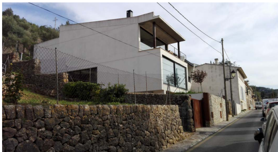
Imagen 6. Carrer de la Llum. Parcelas existentes entre núcleos consolidados, con edificaciones nuevas.
